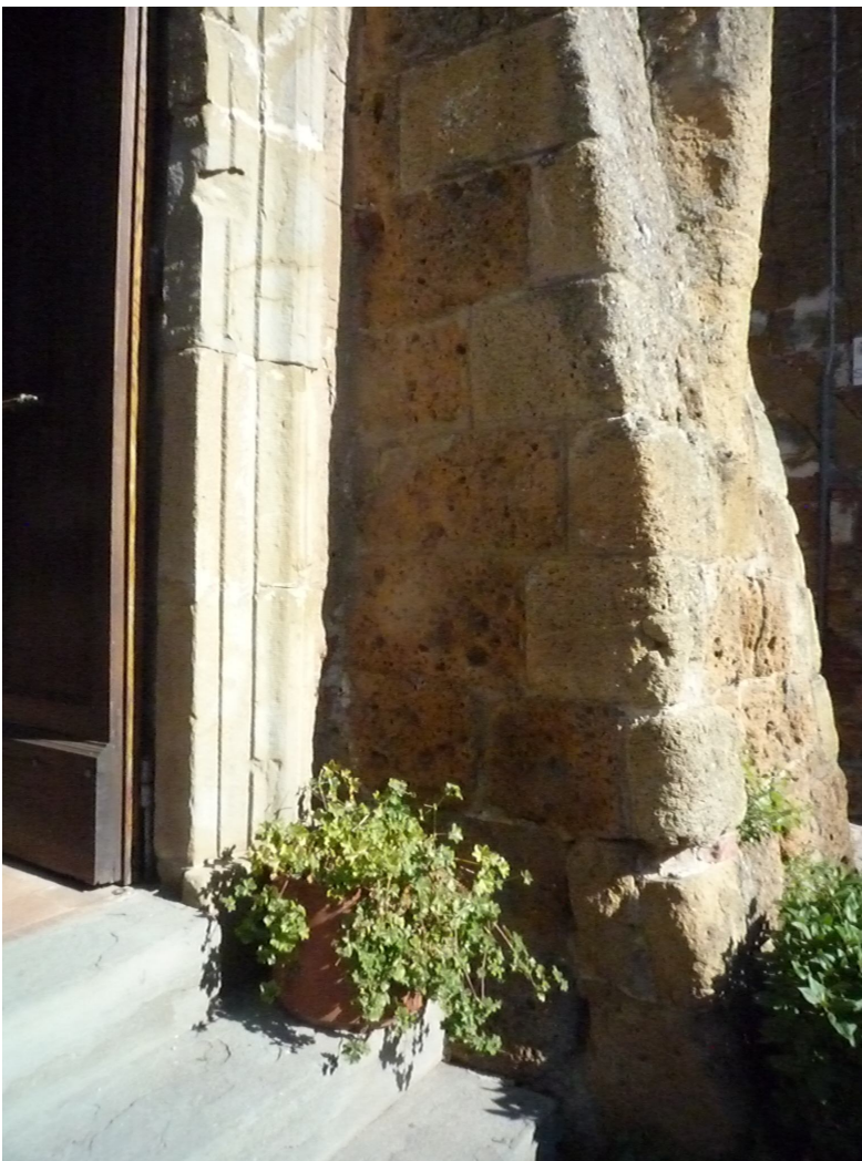
Fig.6. Sovana. Sperone di sostegno in muratura. (foto dell'autore)
