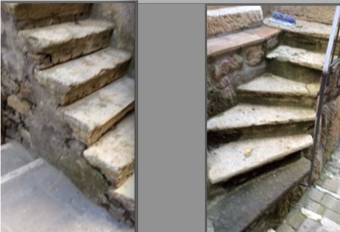
Fig.1. Pitigliano. Accesso alle abitazioni. Gradini in blocco di pietra. (foto dell'autore)
