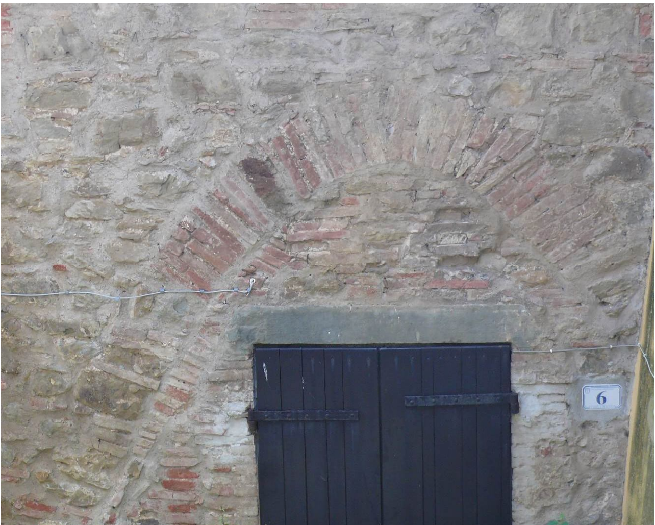
Fig.5. Pereta. Arco di sostegno in una muratura ad opera incerta. (foto dell'autore)
