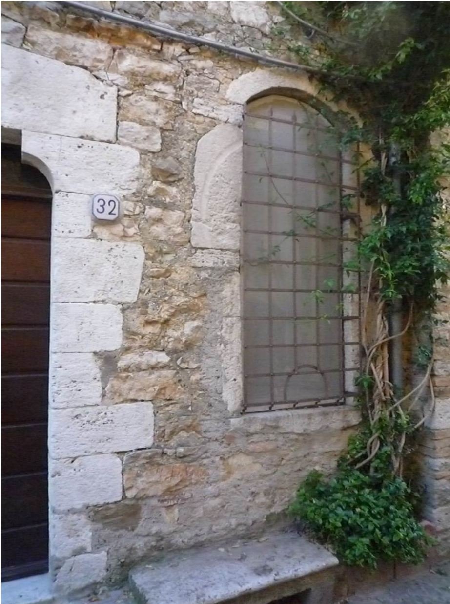
Fig.2. Rocchette di Fazio. Telai di sostegno in pietra attorno a vani porta e finestra. (foto dell'autore)
